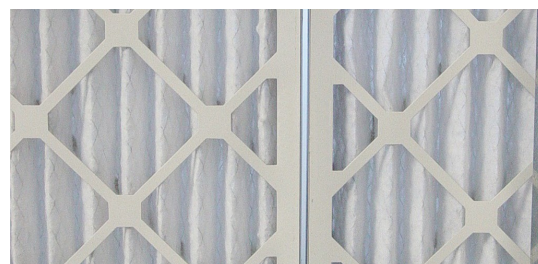
Les interstices entre les cadres des filtres plissés en carton standard permettent le contournement de l'air et des particules.
