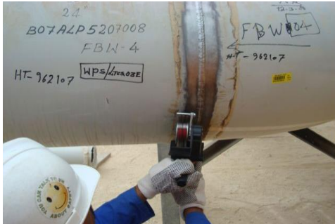
Reinheitsgrad, nach Sa 2½, mit „Bristle Blasting method“
