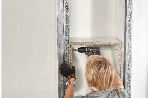
In die Metallständerwand werden seitlich 75-er CW-dB-Profile eingestellt. Daran werden die Wandnischen befestigt.
