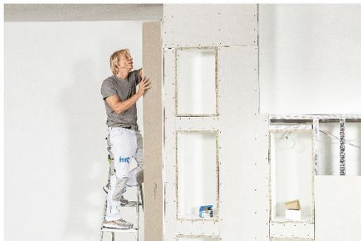
Wenn die endgültige Position der Nischen festgelegt ist, wird die Wand mit Gipsplatten beplankt.
