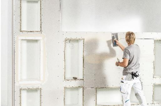
Anschließend wird die Wand mit dem System Uniflott verspachtelt. An den Übergängen der Nischen zur Wand mit Fugendeckstreifen Kurt arbeiten.
