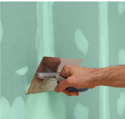
Mit dem geschmeidigen Uniflott Finish imprägniert erfolgt der 2. Spachtelgang bei imprägnierten Feuchtraumplatten.
