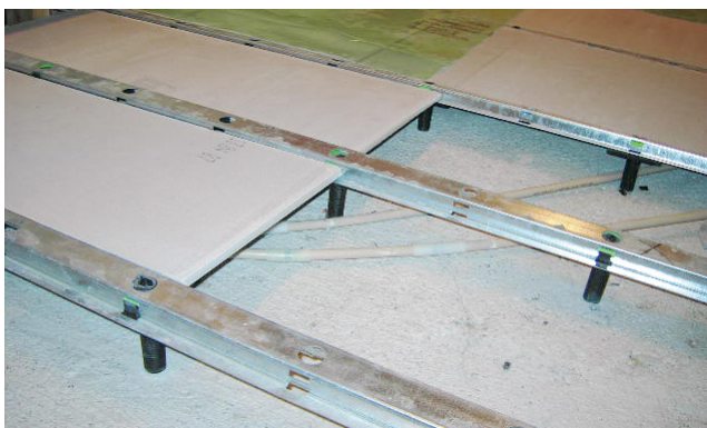
Ventilerat komfortgolv på betongplatta under uppbyggnad. Dubbla skivlag Aquapanel Indoor mellan Granab-reglar.
