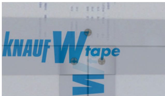
Skruvhål, horisontell och vertikal skivskarv tätad med Knauf W tape
