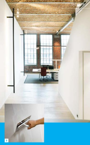
Repasser sur la bande d'armature avec l'enduit, frais en frais.
