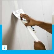
Poser la bande d'armature en papier et empresser légèrement dans l'enduit de jointoiement fraîchement appliqué (toujours tourner le pli du papier vers le support).
