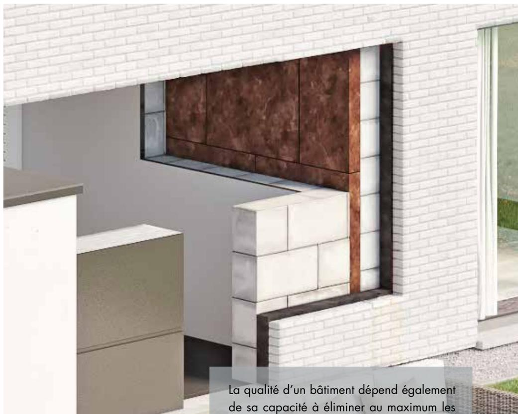
La qualité d'un bâtiment dépend également de sa capacité à éliminer au maximum les nuisances sonores provenant de l'extérieur. Pour le mur mitoyen entre les appartements et les habitations contiguës, ce défi est de taille. Rien ne peut être laissé au hasard pour éviter des ponts acoustiques.
