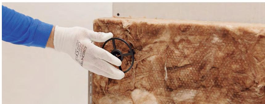
Instalação da lã mineral Naturoll 032 e colocação das fixações.
