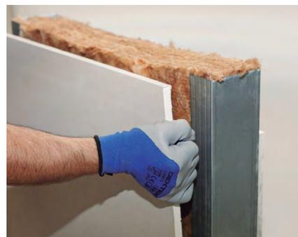
Preencher o perfil de 100 mm com a lã mineral Ultracoustic Plus em 100 mm e aparafusar a placa de gesso aos perfis Aquapanel.
