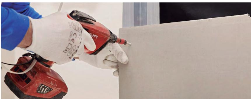
Montar os perfis de aço galvanizado de 100 mm de largura e aparafusar a placa Knauf Aquapanel Outdoor com parafusos Aquapanel Maxi. A placa é contínua e prolonga-se pela frente da laje e dos pilares.
