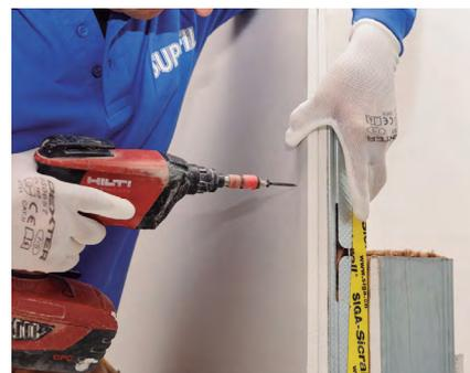
Preenchimento da caixa de ar dos perfis de 48 mm com lã mineral Ultracoustic Plus em 50 mm e revestir com placas duplas de gesso laminado Knauf tipo A. Fixar os suportes da fachada com os fixadores adequados definidos pelo arquiteto.
