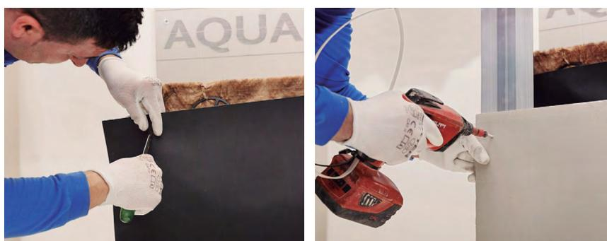
A membrana deve ser cortada nos pontos de encontro com as buchas e bloqueada temporariamente até que seja colocada a estrutura adequada, segundo a fachada ventilada projetada.
