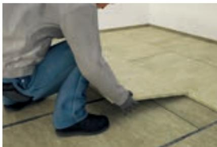
Gleichen Sie nun die Unebenheiten der Rohrdurchführungen mit Knauf Bituperl aus, und verlegen Sie anschließend die Trittschall-Dämmplatten versetzt im Plattenverband.
