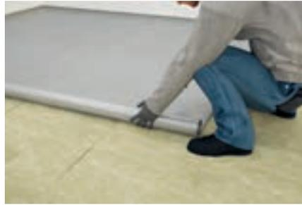
Decken Sie die Dämmplatte mit einer entsprechenden Abdeckung ab.
