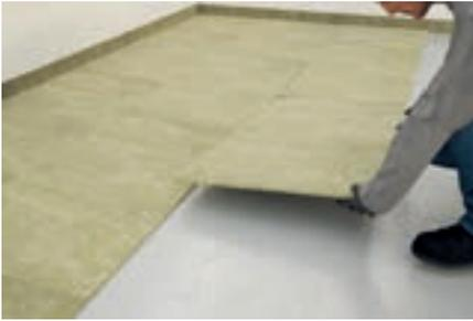
Verlegen Sie zunächst den Randstreifen. Anschließend verlegen Sie die Trittschall- / Wärmedämmplatten im Plattenverband.
