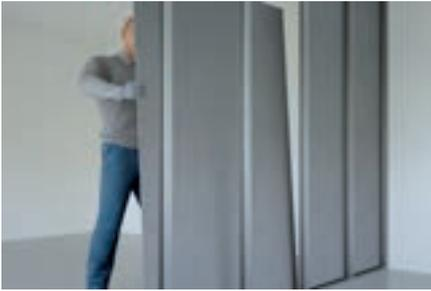
Zunächst die Metall-Unterkonstruktion aufstellen. Danach beplanken Sie eine Seite mit Hartgipsplatten gemäß Herstellerangaben.
