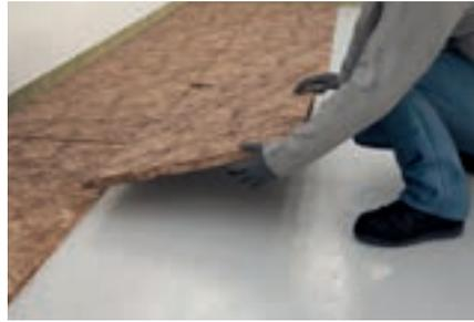
Anschließend verlegen Sie die Trittschall- / Wärmedämmplatten im Plattenverband.
