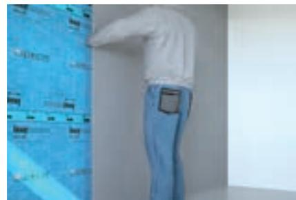
Als letzter Schritt wird die Konstruktion mit Hartgipsplatten, z. B. Knauf Diamant, gemäß Herstellerangaben beplankt und verspachtelt.
