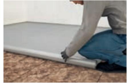
Decken Sie nun die Dämmplatten mit einer entsprechenden Abdeckung ab und bringen Sie dann den Nassestrich auf.
