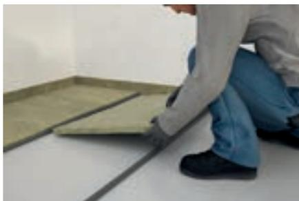
Verlegen Sie zunächst den Randstreifen. Anschließend legen Sie die Dämmplatten als Höhenausgleich ein.
