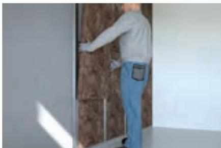
Zunächst wird die Metall-Unterkonstruktion mit Abstand zur Außenwand aufgestellt. Danach wird der Dämmstoff lückenlos eingebaut.
