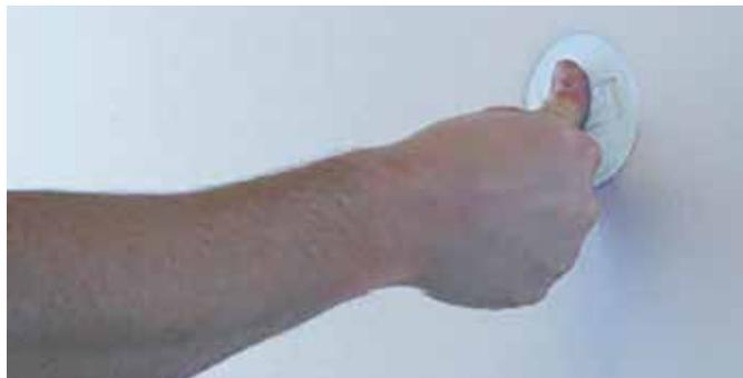
5. Un trou percé à l'aide d'une alène facilite le vissage. Il n'est pas nécessaire de préforer.
