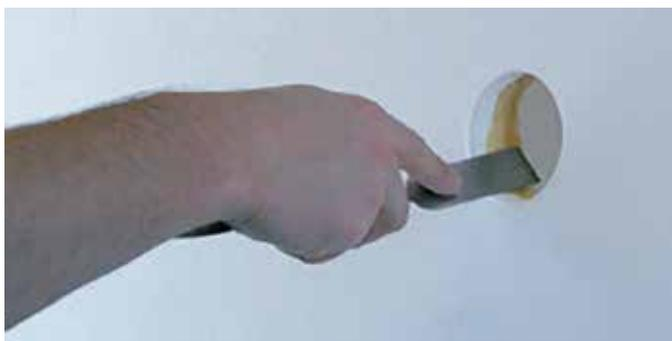
3. Appliquer la colle PU sur la surface arrière du cylindre de montage Zyrillo, en boudin ou par plots. Consommation indicative par cylindre de 70 mm de diamètre : 16 à 20 ml.
