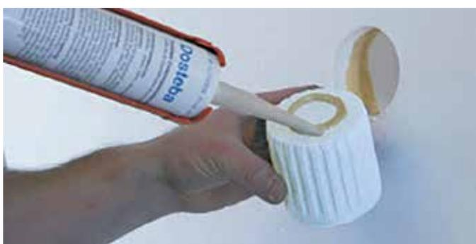
4. Enfoncer les cylindres de montage Zyrillo à fleur des panneaux isolants. Marquer la position exacte pour que les cylindres puissent être retrouvés aisément après les travaux d'enduisage.
