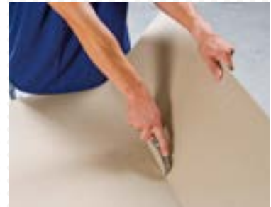
Breken van de plaat en doorsnijden van het rugzijdekarton.
