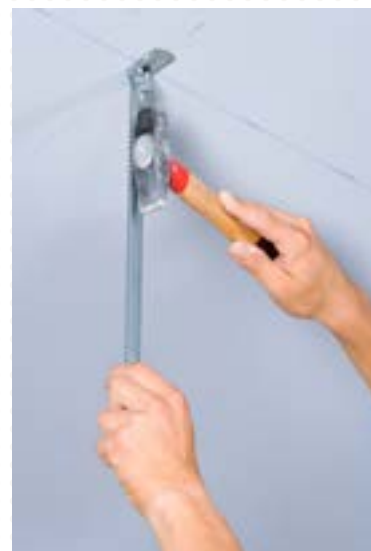
Bij omgezette bevestigingslip zo dicht mogelijk bij de hoek verankeren (hier met Knauf Slagplug Metaal).
