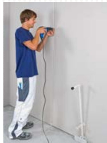
Een platenhevel helpt om de platen 10 mm vrij te houden van de vloer (levering derden).
