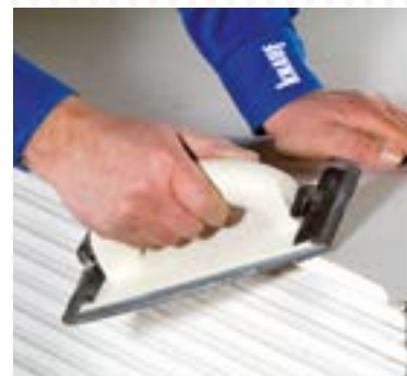
Het zichtzijdekarton langs de kopse kant 'breken' met het handschuurblok.
