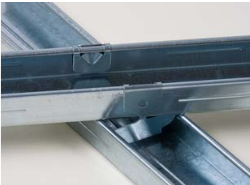
Niet-haakse profielverbinding met 2 Draaiverbinders.
