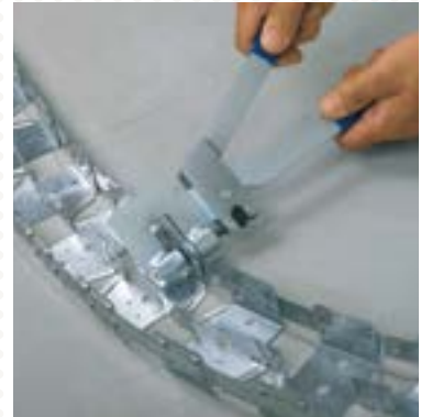
Om de radius te fixeren stanst men de stalen band aan de zijanten van het Sinus profiel vast.
