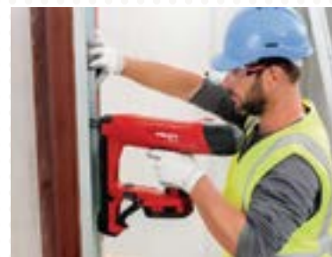
Bevestiging met accuschiethamer van een wandprofiel op een stalen kolom (foto: Hilti).
