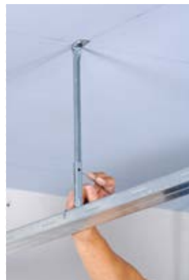
De Nonius splint dient te worden omgebogen als borging.
