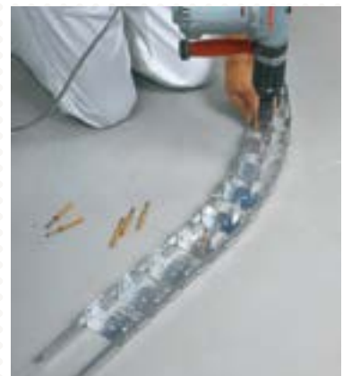
Bevestiging van Knauf Sinus profiel op de vloer.
