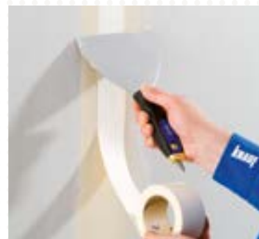
Wapenen van de kopse naad door een voegband (papier- of glasvezelstrook) in de voegmortel in te bedden.
