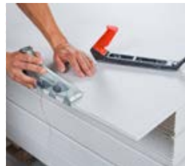
Gebruik van de kantenschaaf.
