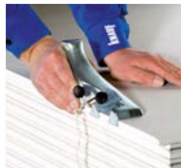
De kopse kant facet schaven met de Knauf Kantenschaaf.
