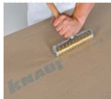
Karton perforeren met een behangperforator.
