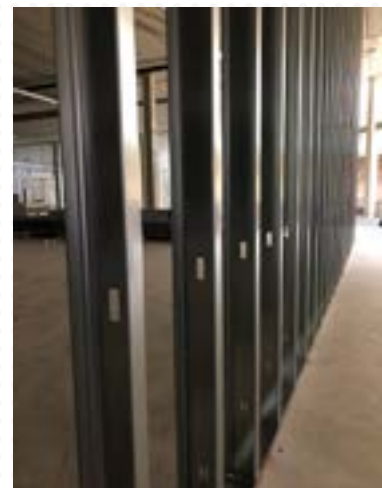
Openingen in de profielen op gelijke hoogte vergemakkelijken het horizontaal doorvoeren van kabels.
