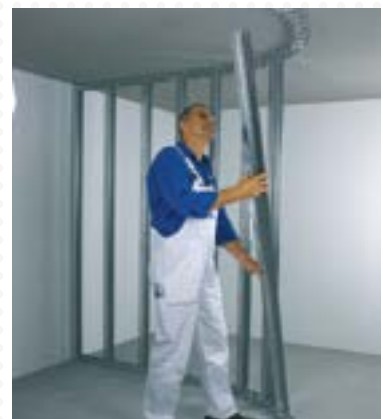
Wandstaanders plaatsen tussen de Knauf Sinus profielen.
