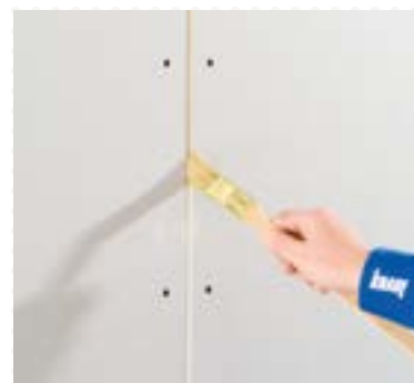
De gipskern gronderen met Knauf Diepgrond om hechting te bevorderen en zuiging te verminderen.
