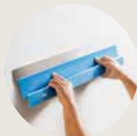
Skimming - Volvlakig plamuren (F2b/F3)
