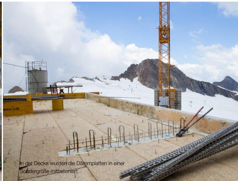
In der Decke wurden die Dämmplatten in einer Sondergröße mitbetoniert.
