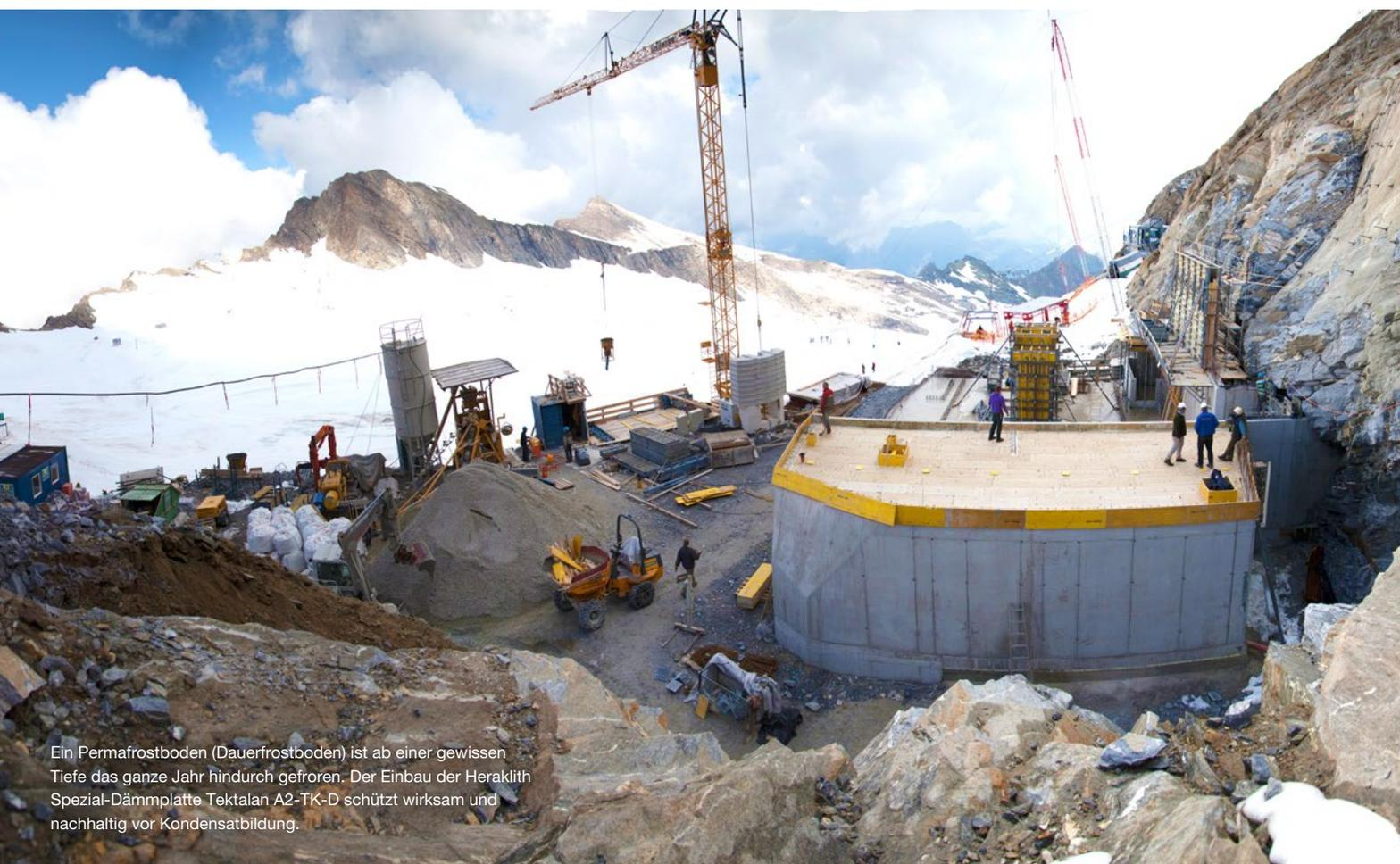
Ein Permafrostboden (Dauerfrostboden) ist ab einer gewissen Tiefe das ganze Jahr hindurch gefroren. Der Einbau der Heraklith Spezial-Dämmplatte Tektalan A2-TK-D schützt wirksam und nachhaltig vor Kondensatbildung.
