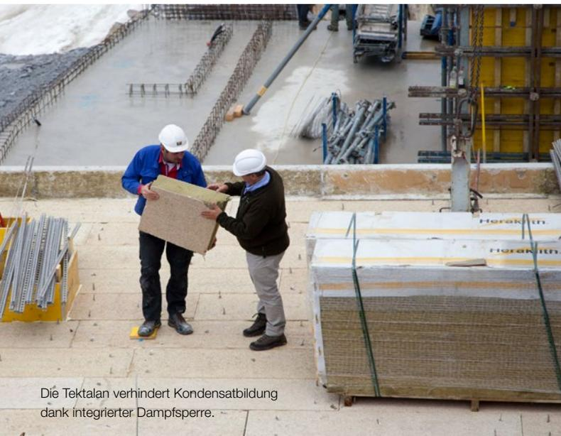
Die Tektalan verhindert Kondensatbildung dank integrierter Dampfsperre.
