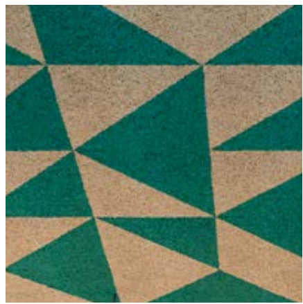
Motifs géométriques appliqués de façon aléatoire sur les dalles
