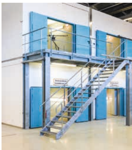
Εξωτερική όψη του θαλάμου ελέγχου για οροφές
