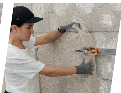
ThermaSoft® natura de par sa flexibilité, s'adapte facilement à l'ossature métallique et aux appuis intermédiaires.
