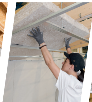
Mise en place de l'isolant sur ossature métallique.
