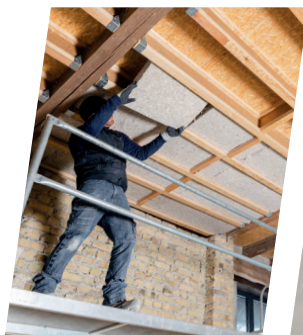
Mise en place entre chevrons.
