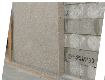
Pose directe de l'isolant contre la paroi extérieure.
