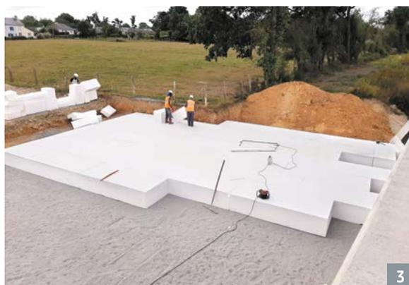
1 Approvisionnement du chantier en blocs de Knauf Geofoam TP 150
