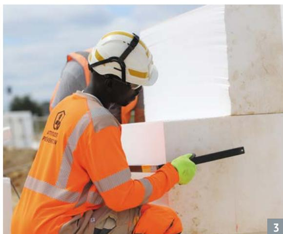
1. Approvisionnement du chantier en blocs de Knauf Geofam TP
