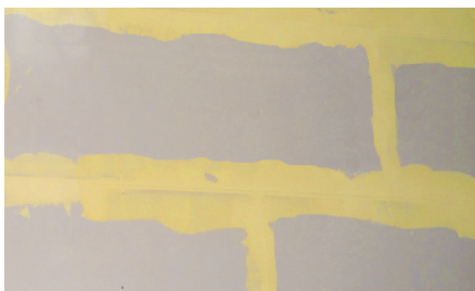
Vullen van de voegen met de gele Safeboard Filler zorgt voor maximale veiligheid.
