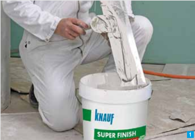
Ανάμιξη του υλικού με το χέρι
