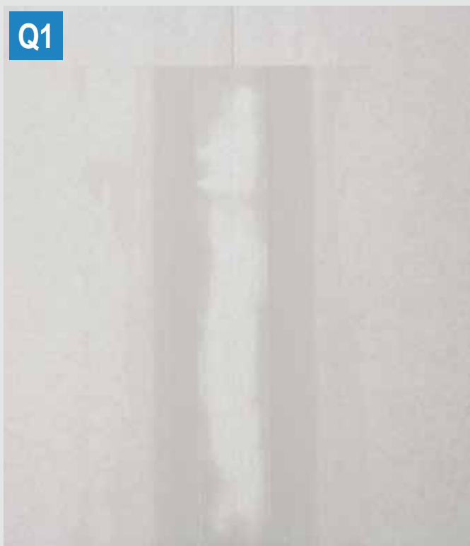
Q1: Knauf Fugenfueller σε άκρα ΑΚ με χαρτοταινία Kurt
