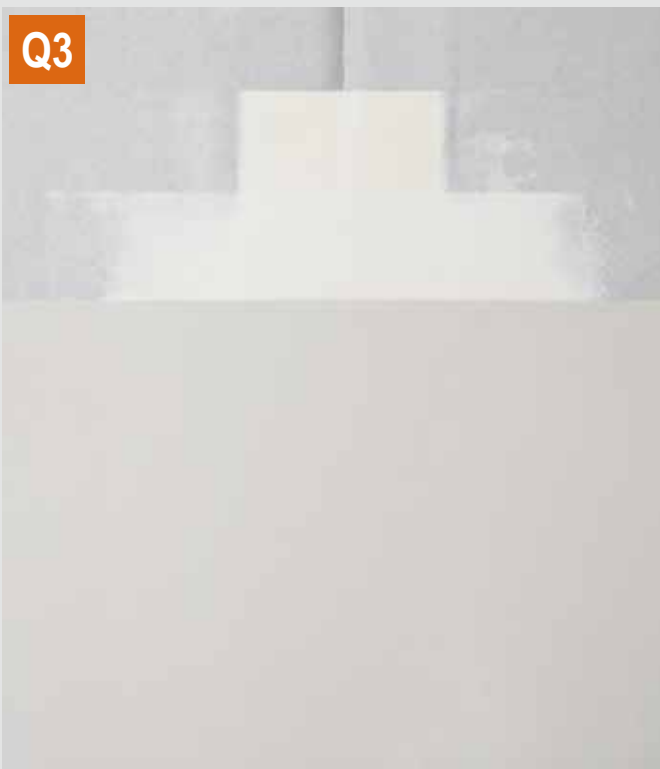
Q3: Knauf Uniflott σε άκρα HRAK σπατουλάρισμα - σερτικάρισμα όλης της επιφάνειας με Knauf Super Finish
