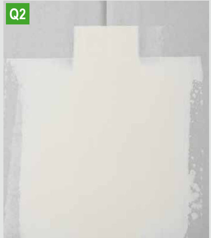
Q2: Knauf Uniflott σε άκρα HRAK (δεύτερο χέρι)
