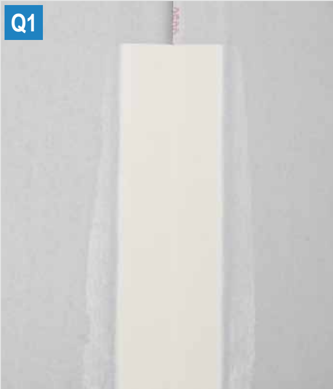
Q1: Knauf Uniflott σε άκρα HRAK
