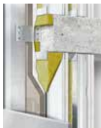
Dvostruka potkonstrukcija s međupločom
