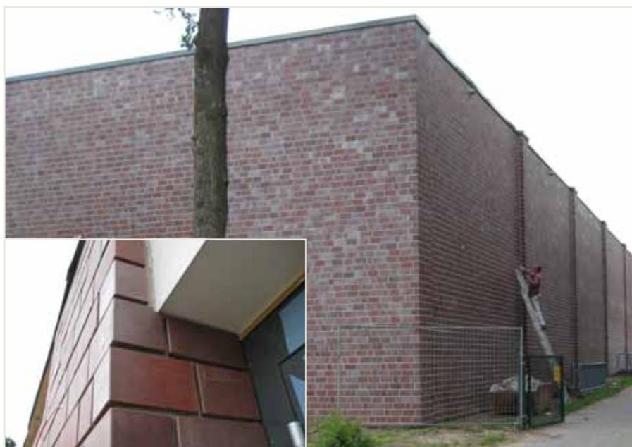
Bringen Sie die Klinker oder Fliesen nicht bei Frost und unter Vermeidung von Fehlstellen (Kleber) auf. Wählen Sie geeignete Kleber entsprechend den Empfehlungen des Herstellers für Zementuntergründe.
