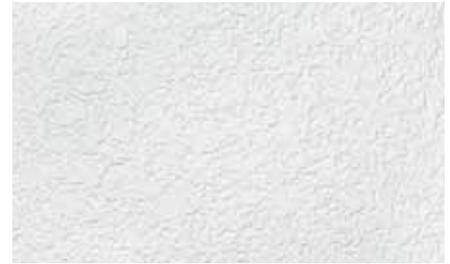
Der Rillenputz ist eine Putzstruktur, für die ein Mörtel mit rundem Strukturkorn mit einer Glättkelle aufgetragen, scharf abgezogen und gerieben wird. So bildet sich eine mehr oder weniger ausgeprägte Rillenstruktur, die sich je nach Korngröße wesentlich voneinander unterscheidet.
