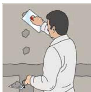
Jetzt ist die Gebäudehülle geschlossen und schützt vor Witterungseinflüssen. Die so verspachtelte Plattenfläche kann bis zu sechs Monate frei bewittert werden. Die Platten müssen vor dem Verputzen gesäubert und abgetrocknet sein. Offene Schnittkanten schützen. Mit dem Innenausbau kann begonnen werden, bevor die Oberfläche im Außenbereich gestaltet wird.
