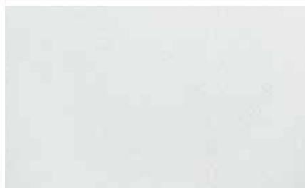
Wer ein dezentes Erscheinungsbild wünscht, ist mit einer gefilzten Putzstruktur bestens beraten. Er vermeidet eine völlig glatte Oberfläche und hält sich zugleich mit deren Strukturierung zurück. Ein Filzputz wird mit der Kelle oder einem Spachtel aufgetragen und mit einer Schwammscheibe abgefilzt. Dadurch wird das feine Strukturkorn an der Oberfläche sichtbar.
