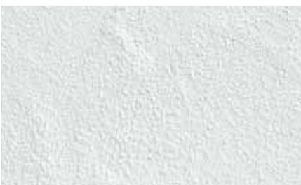
Wer Ausgefallenes mag und etwas für besondere Strukturen übrig hat, entscheidet sich für den Modellierputz. Dieser wird in beliebiger Dicke aufgetragen und anschließend ganz nach Geschmack mit einer Kelle oder einem Spachtel frei strukturiert. Werden die strukturierten Flächen anschließend noch mit einer Quaste verbürstet, entsteht eine verwachsene Struktur.
