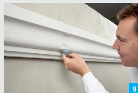
Nach einem Tag Standzeit können die verbliebenen Fugen mit dem beigefügten Fugenmörtel verspachtelt werden.
