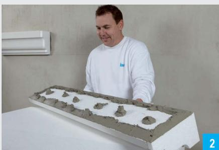
Die Verklebung auf der Rückseite des Profils erfolgt mit Knauf Duo-Kleber in Punkt-Rand-Verklebung.
