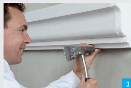
Profile nach Verlegeplan fluchtrecht anbringen (leicht schiebend) und alle Übergänge lochfrei zuspachteln. Falls erforderlich, gegen Abrutschen sichern.
