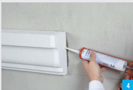
Knauf Spezial-Montagekleber auf einer Seite vom Profilstoß anbringen. Schnittstellen vor dem Kleben von Staub reinigen.
