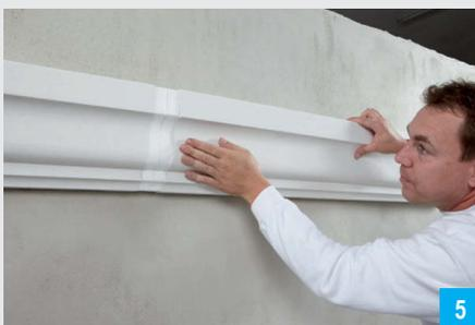
Nach dem Montagekleberauftrag das nächste Profil innerhalb von 5 Minuten anbringen und fluchtrecht ausrichten.
