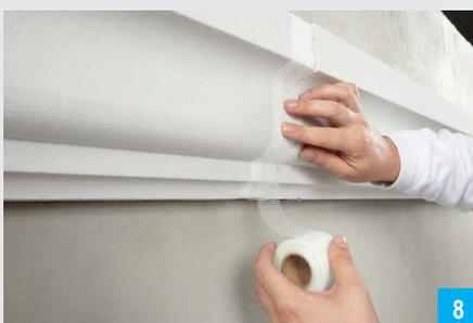
Bei Profilen mit Auskrägungen  $\geq 150$  mm selbstklebende Gewebestreifen am Profil in die dafür vorgesehenen Ausklinkungen anbringen. Darauf achten, dass die Streifen an allen Stellen gut anliegen. Die Gewebestreifen sind im Lieferumfang enthalten.
