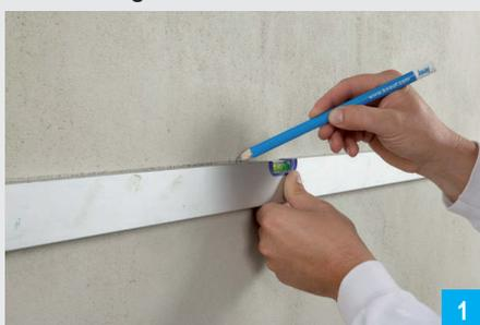
Verlauf der Fassadenprofile mittels Wasserwaage, Schnur, etc. auf dem vorbereiteten und tragfähigen Untergrund (siehe oben) anzeichnen.
