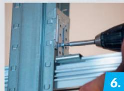
Schrauben ermöglichen exaktes Justieren der Höhe vor dem Festschrauben.
