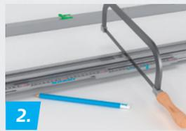
Tragschiene und Laufschiene können bei schmaler Wandöffnung leicht auf das nötige Maß gekürzt werden.
