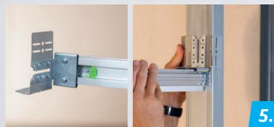
Sicherungslaschen am Anschlusswinkel (passend für 75er und 100er Profile) sorgen für mittige Ausrichtung und sichern die Tragschiene bei der Montage.
