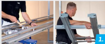
Ständerprofile mit den Traversen einfach vormontieren und am Stück in die Wandkonstruktion einstellen.
