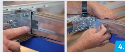
Ein Montageclip sichert die Position für das Anschrauben der Tragschiene.
