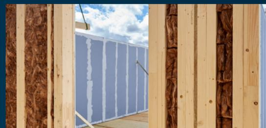
Eine Aufstockung in Holzrahmenbauweise minimiert nicht nur den Baumaterialbedarf erheblich sondern verbessert zudem die Dämmung der obersten Geschossdecke des Bestandsbaus und erfüllt neueste Standards für eine energetische Modernisierung.
