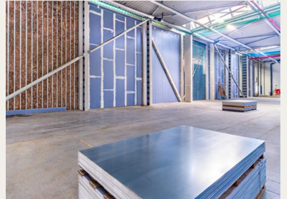
Seit 2020 nutzt der Reifen- und Felgengroßhändler Interpneu das Logistikzentrum in Karlsruhe-Hagsfeld als Lager- und Fertigungszentrum. Dies machte einen aufwendigen Umbau mit brandschutztechnischer Ertüchtigung inklusive einer über 8 m hohen Brandwand W131 erforderlich.
