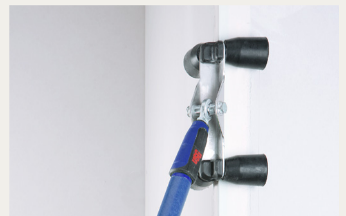
4 Andrücken mit Innen- bzw. Außeneckroller
