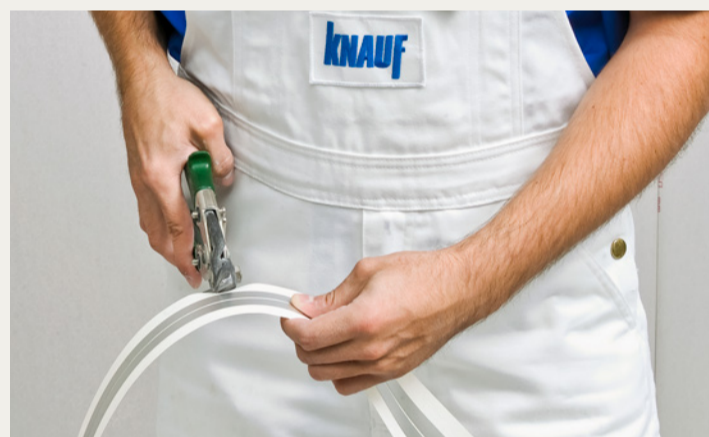
1 Schienen mit Blechschere passend ablängen
