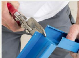
Korrosionsgeschützte CW Profile mit  $\leq 1\text{mm}$  Materialdicke schneiden Sie einfach mit der Blehschere von Hand oder elektrisch.
