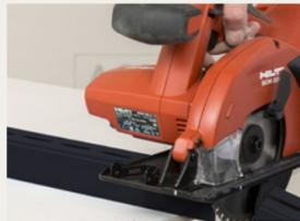
Beschichtete UW Profile  $\geq 1\text{mm}$  Dicke sollten Sie mit einer langsam laufenden Kreissäge schneiden.
