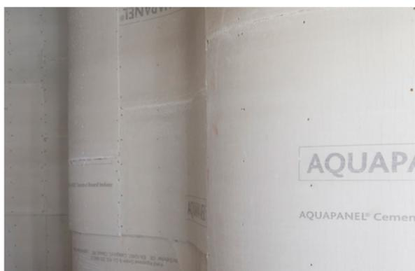
AQUAPANEL® Cement Board Indoor lässt sich ohne Festigkeits- und Funktionsverluste ab einem Biegeradius von 1 m trocken biegen.
