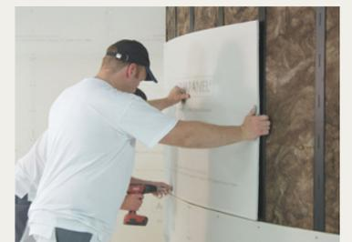
3 An gerundete Unterkonstruktion schrauben
