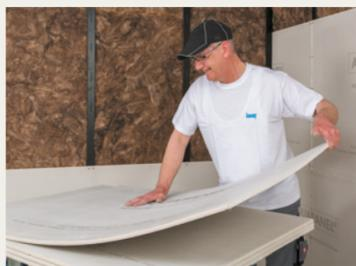
1 Plattenstruktur mechanisch lockern, im Liegen ...
