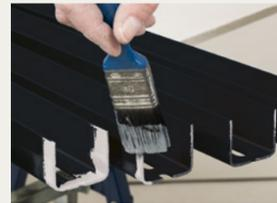
Korrosionsgeschützte Profile müssen an den Schnittkanten mit dem grauen Korrosionsschutzlack C3/C5M nachbeschichtet werden, um vollflächigen Schutz zu erhalten.
