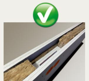
Alternativ gewährleisten Sie den Schallschutz auch durch eigens angefertigte GK-Einhausungen mit normalen Dosen.
