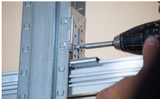
31. Verschrauben Sie alle Aufhängungen mit je sechs Blechschrauben LN 3,5x11 an den Anschlusspunkten, siehe [Bild 35](#).
