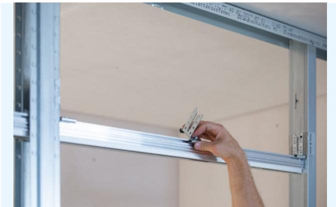
35. Wenn der Abstand  $a \geq 260$  mm zwischen der Decke und der Verbindungsplatte des Ständerprofils ist, dann montieren Sie ein UW-Profil in Wandunterkonstruktionsstärke mittig an die Verbindungsplatten der Ständerprofile mit je zwei Blechschrauben LN und setzen in Verlängerung der Ständerprofile jeweils ein CW-Profil, siehe [Bild 39/Bild 40](#).
