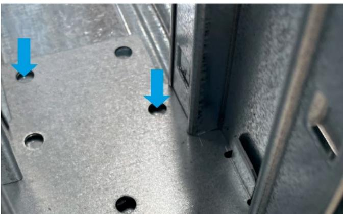
34. Schrauben Sie die Winkel zur Montage der im Sturzbereich liegenden CW-Profile an und montieren Sie die CW-Profile passend zum Wandständerachsabstand. Verschrauben Sie diese mit Blechschrauben LN 3,5x11, siehe [Bild 38](#).
