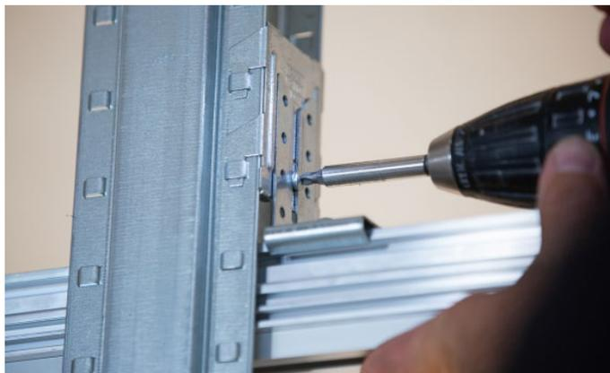
29. Richten Sie die Tragschiene waagrecht aus (nur nach oben ausrichten) und fixieren Sie diese mit Blechschraube LN 3,5x11, siehe [Bild 33](#).
