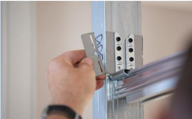
33. Befestigen Sie die Verbindungsplatten mit je zwei für den Untergrund geeigneten Befestigungsmitteln, siehe [Bild 37](#).
