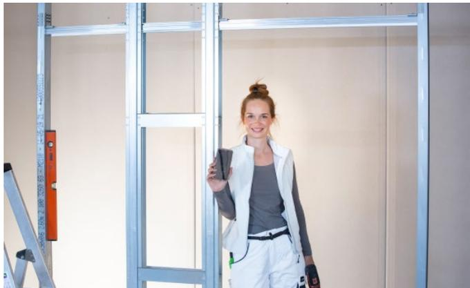
38. Beplankung der Wand nach den Angaben des Wandsystems. Im Bereich der Pocket Kit Easy Türeinflauchtasche müssen die im Lieferumfang enthaltenen Schnellbauschrauben verwendet werden, um spätere Beschädigungen des Türblattes zu vermeiden, siehe **Bild 43**. Halten Sie einen Luftspalt unter den Platten zum Boden von 10 mm ein.
