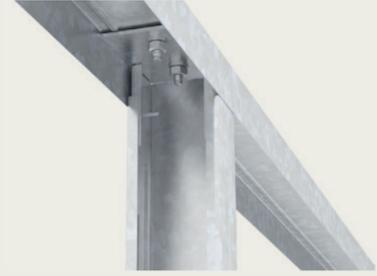
Gleitwinkel mit Bolzenankern befestigen und verschrauben.
