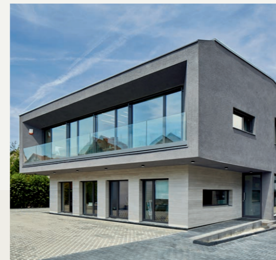
Stahl-Leichtbau Einfachständerkonstruktion mit WDVS
