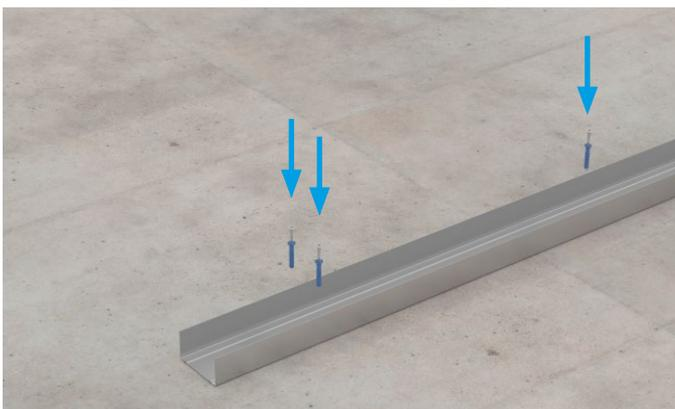
Bild 2: Pocket Kit Höhenausgleich in UW-Profil einsetzen
