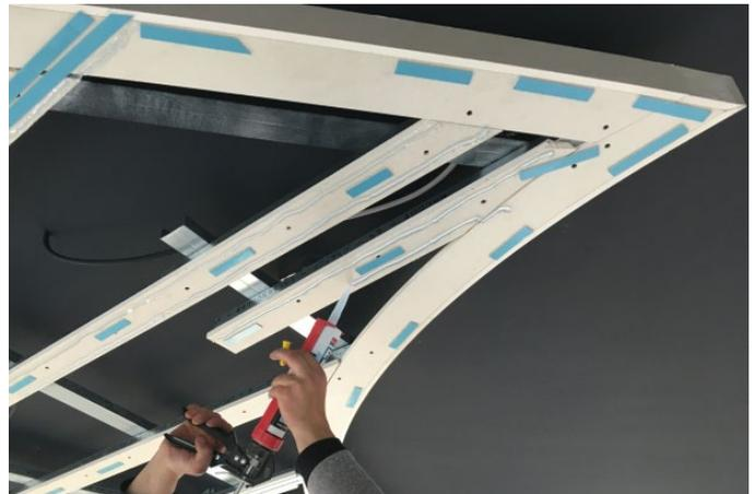
5 Gleichmäßiges Auftragen des Montageklebers. Raupenspur Montagekleber dicker als Spiegelklebeband. Ca. 15 mm Abstand zum Spiegelklebeband.
