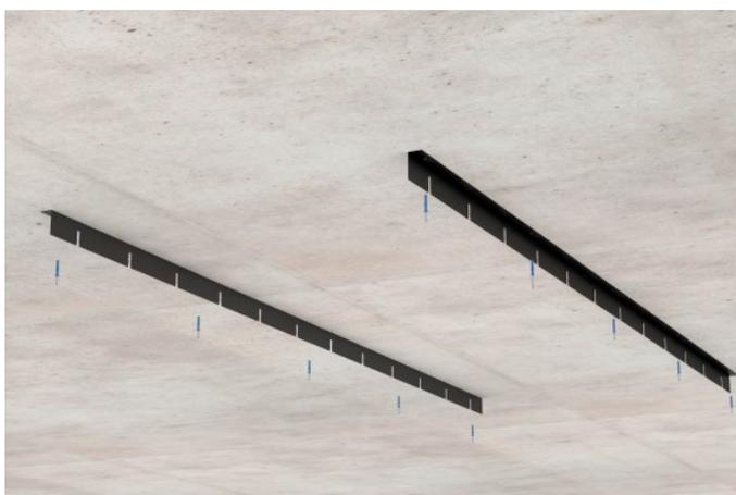
3 Abstände und Parallelität prüfen. Befestigungsschienen montieren.
