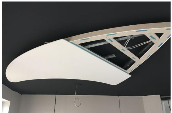
6 Entfernen der Applikationsfolie des Spiegelklebebandes. Aufkleben der Cleaneo Smart 10 durch andrücken.
