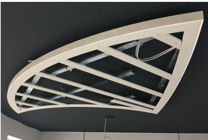
3 Aufbringen der Knauf Plattenstreifen auf die Unterkonstruktion.
