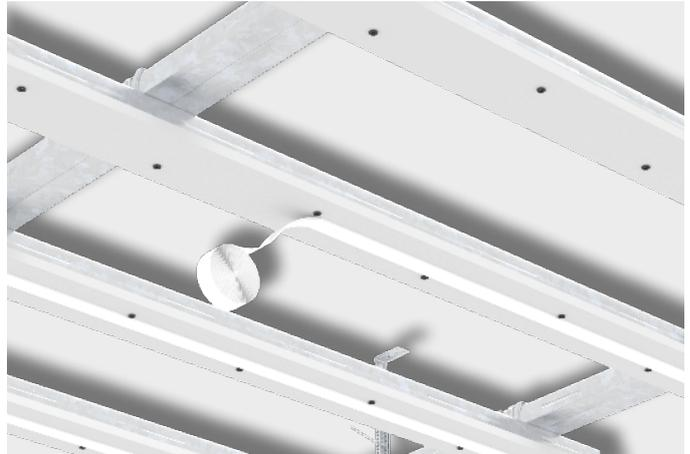
**4** Aufbringen des Spiegelklebebandes (2 mm dick) auf die Knauf Plattenstreifen.
