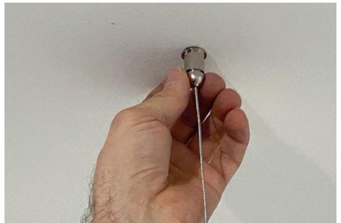
5 Befestigungspunkte an der Decke markieren, Hülsen anschrauben und Seile einschrauben.
