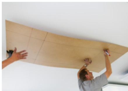
1. Übertragen Sie die 4 Abhängepunkte z. B. mit einer selbst angefertigten Schablone an die Decke
