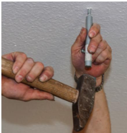
3. Montieren Sie das für den Untergrund geeignete Befestigungsmittel und befestigen Sie die Hängersockel z. B. bei Beton mit Fischer Nagelanker FNA II 6 mit M6 Gewinde oder bei Holz mit Knauf Schnellbauschraube mit Grobgewinde TN 3,9 x 35.
