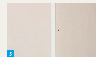
5. Gipsplatten mit ca. 5 mm Abstand montieren
