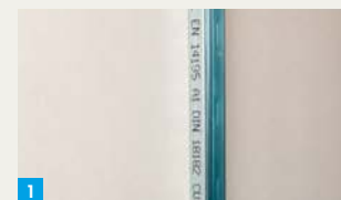
1. Profil auf angrenzendes Bauteil montieren
