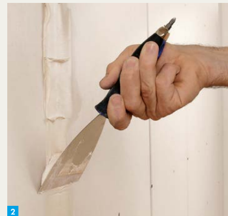
2. Mit dem Schraubgriffspachtel scharf abziehen.
