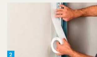
2. Trenn-Fix neben Profil kleben
