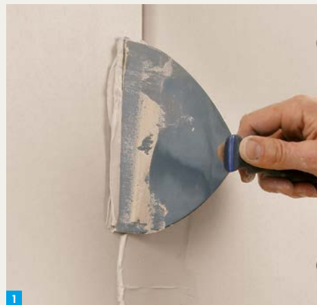
1. Knauf Uniflott in die Gipsplattenfuge einbringen.
