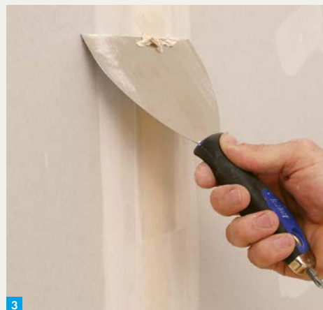
3. Ausgehärtetes Material nach ca. einer Stunde abstoßen.
