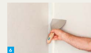
6. Fuge mit Uniflott verspachteln
