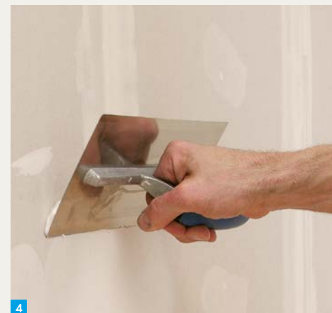
4. Knauf Uniflott Finish mit der Traufel auftragen und glatt abziehen. Nach Trocknung gegebenenfalls schleifen.
