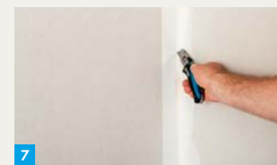
7. Nach Trocknung und Schleifen Trenn-Fix in der Ecke einschneiden
