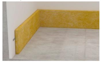
Fertighöhe des Estrichs an allen aufgehenden Bauteilen markieren und Randdämmstreifen Mineralwolle mit Oberkante mindestens 5 mm höher wie Fertighöhe fixieren.
