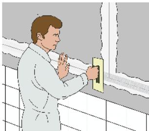
3. Alle Schraubköpfe verspachteln. Gegebenenfalls nach der Trocknung mit einem Handschleifer Unregelmäßigkeiten an den Schraubblöchern entfernen.
