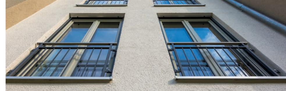
Sicher und ästhetisch: Französische Balkone an gedämmten Fassaden.
