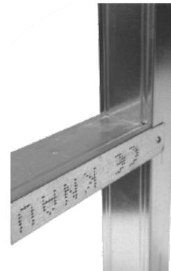
Perspektive – Stützenprofil 2x CW, Brüstungsprofil 1x UW
