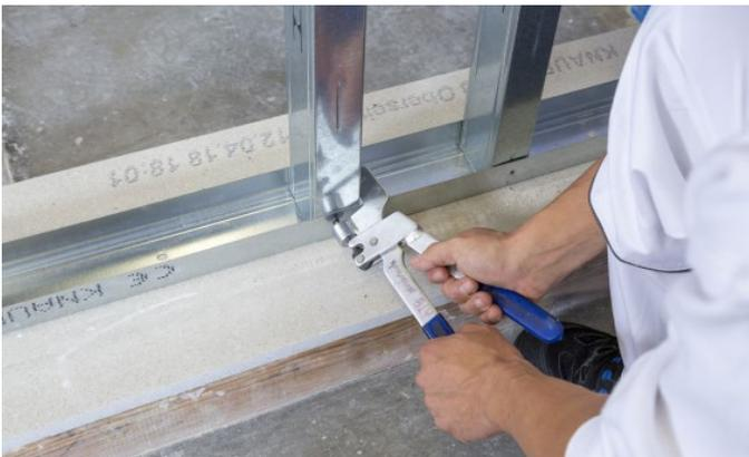
Bringen Sie das senkrechte Anschlagprofil mit der geschlossenen Seite in Richtung Öffnung an und vercrimpen oder vernieten Sie dieses.
