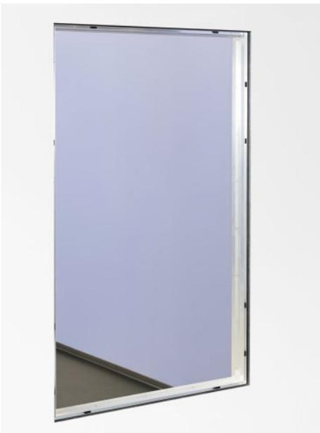
Verspachteln Sie die Fugen (Knauf Uniflott) und stellen Sie die Wand fertig.
