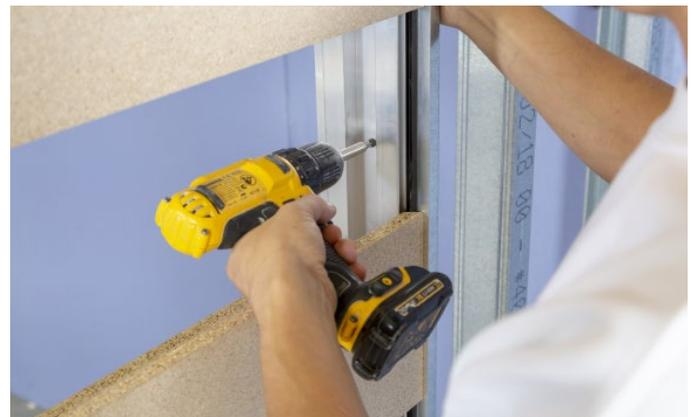
Verschrauben Sie den Rahmen des FlatWin mit dem einseitig gestellten Anschlagprofil. Es kann für die Ein-Mann-Montage eine Montagehilfe verwendet werden, oder Sie können zu zweit arbeiten. Verschrauben Sie die Blechschrauben LN 3,5 x 11 mm in einem maximalen Abstand von 200 mm in den vorgebohrten Löchern.
