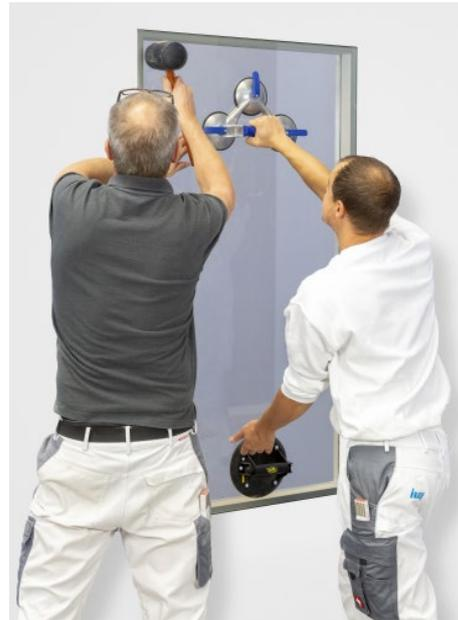
Setzen Sie, mit Hilfe zweier Saugheber, die Glasscheiben ein und lassen Sie diese im Grundrahmen einrasten. Wiederholen Sie den Vorgang mit der gegenüberliegenden Verglasung.
