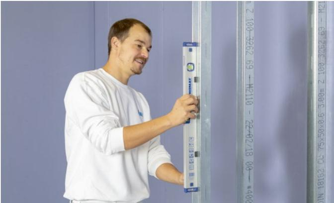
Stellen Sie das senkrechte Anschlussprofil auf. Die Montage der Metallständerwand erfolgt in gewohnter Weise.
