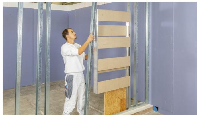
Verschrauben Sie das zweite Profil wie das erste senkrechte Anschlagprofil mit dem Fensterrahmen.
