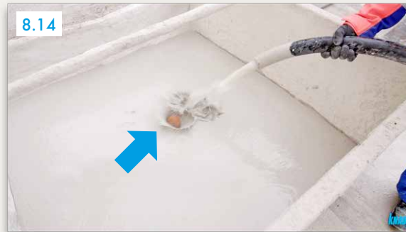
Schlauch mit Wasser durchspülen bis Schwammkugel austritt
