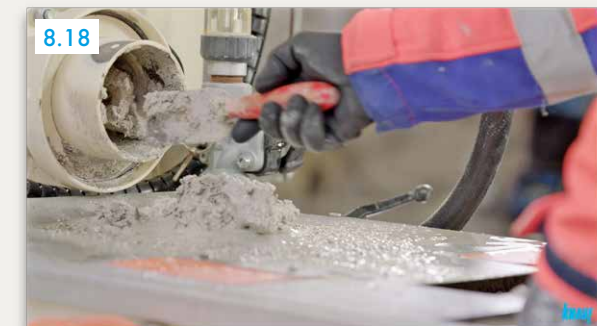
Trockenbereich und Dosierschnecke mit Spachtel säubern
