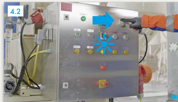
„Steuerspannung Ein“ (grüner Knopf) drücken ▶ Licht an
