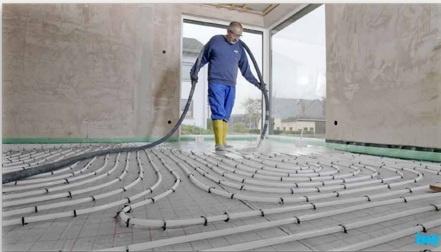
Mörtel mit Schlauch in der Fläche verteilen
