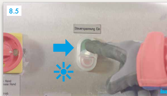
8.5 „Steuerspannung Ein“ (grüner Knopf) drücken ▶ Licht an
