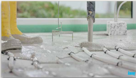
Mörtel mit Schlauch in der Fläche verteilen
