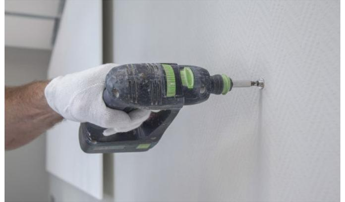
4. Schrauben Sie die Magnetsockel mit geeigneten Befestigungsmitteln an der Wand fest, siehe Bild 6.
