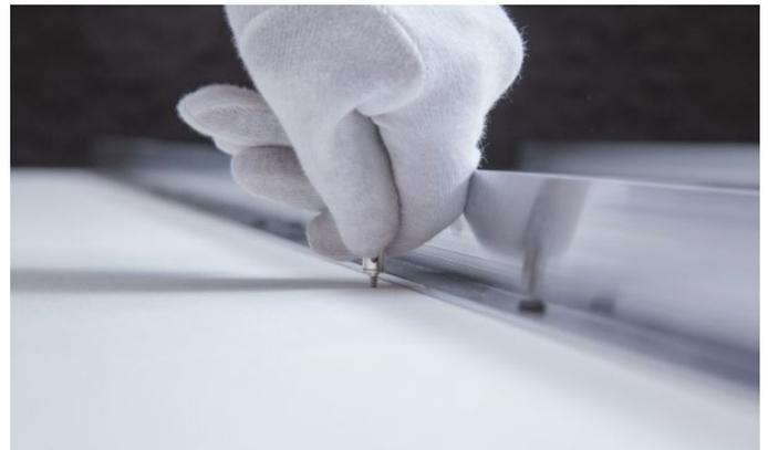
5. Schrauben Sie die Hängerunterteile in das Deckensegel, siehe Bild 18. Maßangaben siehe Bild 15 bzw. Bild 16.
