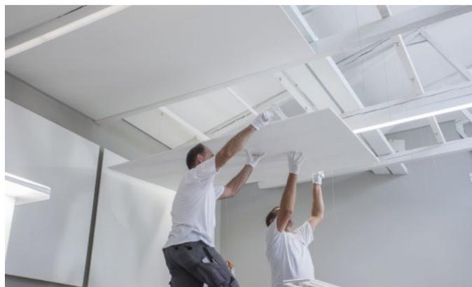
9. Richten Sie das Deckensegel mittels der Justierfunktion der Hängerunterteile aus, siehe Bild 22.
