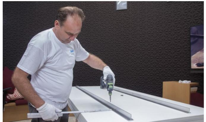
4. Positionieren Sie die T-Schiene entsprechend Bild 16 auf dem Deckensegel. Verschrauben Sie die T-Schienen abwechselnd im Abstand von maximal 300 mm mit Flachkopfschrauben 3,9 x 9,5 mm, siehe Bild 17.
