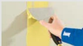
Knauf Safeboard Spachtel za obradu spojeva Safeboard ploča.
