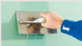
Knauf Uniflott impregnirani za obradu spojeva impregniranih ploča.
