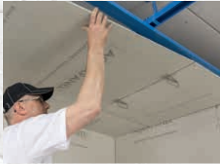
1 Platten mit 4 mm Fugenabstand montieren
