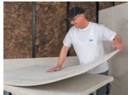
1 Plattenstruktur mechanisch lockern, im Liegen ...
