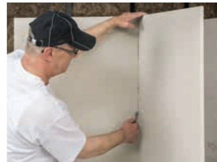
3 Gewebe auf der Rückseite durchtrennen
