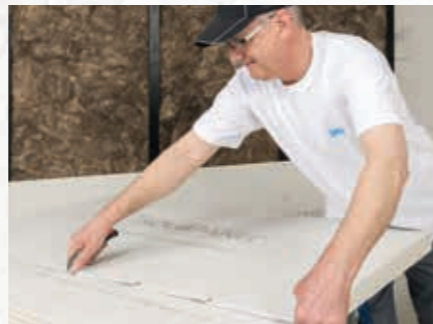
1 Platte bauseits tief einritzen
