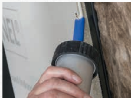
2 Kleberraupe über die ganze Kante auftragen
