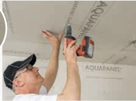
3 Ohne Vorbohren verschrauben
