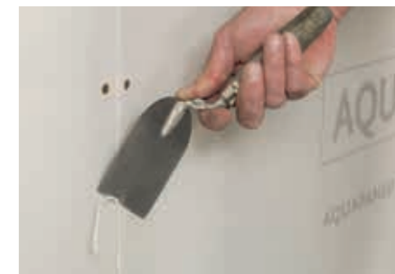
4 Nach einer Trocknungszeit von ca. 12 – 16 Stunden* (am Folgetag) wird der überstehende Kleber abgestoßen.
