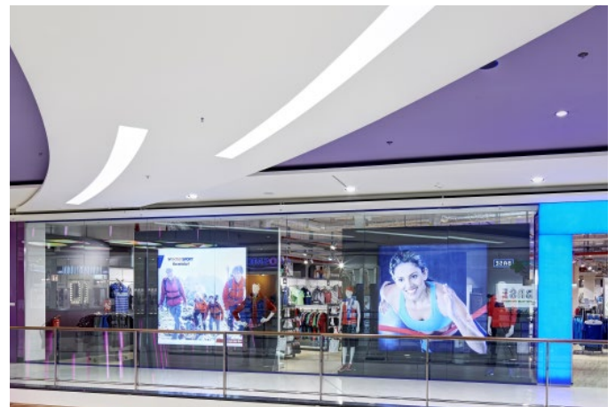
Frei geformte Deckensegel mit integrierten geschwungenen Lichtvouten setzten die Gänge und Galerien ins rechte Licht. Die Segel bestehen aus zehn bis zwölf vorgefertigten Einzelementen.
