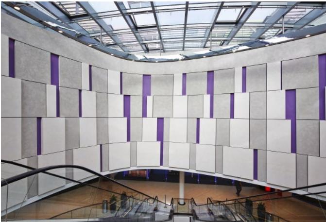
Die farbigen, in unterschiedlichen Radien gebogenen Elemente der Reliefstrukturen an den Wandflächen der Mall-Augen bestehen aus vorgefertigten Gipsplatten.
