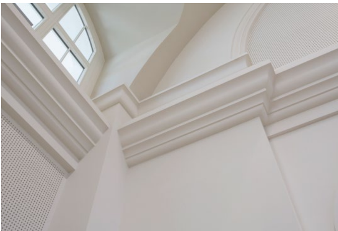
Gesimse ab Werk: Faltechnik mit Stuck kombiniert.
