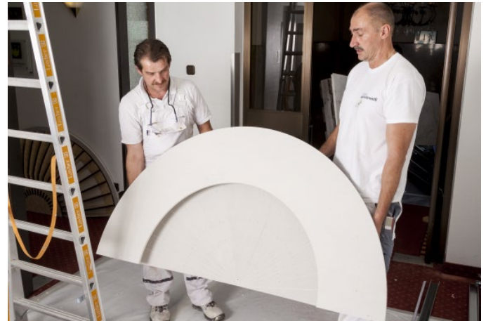
Die Einzelteile der Kuppel wurden in Segmenten angeliefert.
