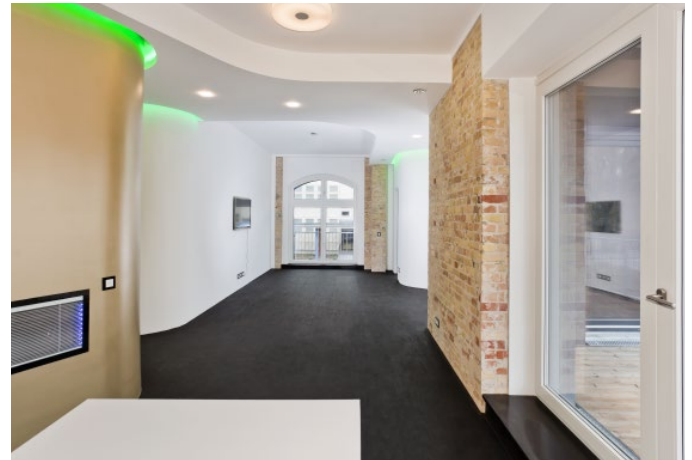
Die Wohnungstrennwände auf der Basis des Knauf System W115.de als Doppelständerwand, beplankt mit Knauf Diamant und Knauf Piano, erreicht ein bewertetes Schalldämm-Maß R'_w von 65 dB. Das sind 12 dB mehr als die Mindestanforderung nach DIN 4109.
