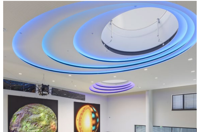
Eine anspruchsvolle Deckenkonstruktion prägt das Foyer des Max-Planck-Institutes für Sonnensystemforschung in Göttingen. (Foto: Knauf/Braun)
