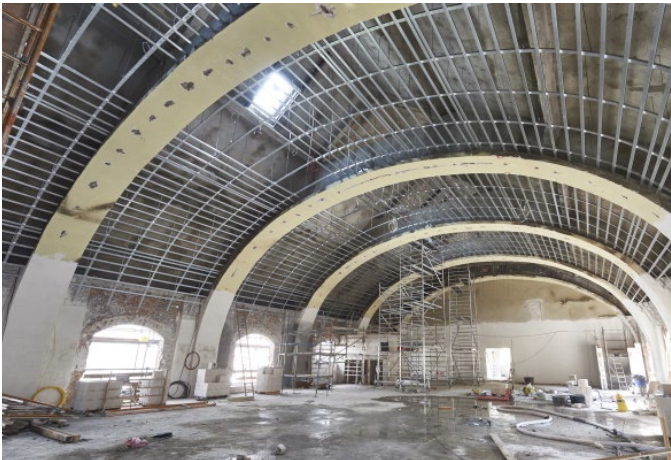
Die Unterkonstruktion, an der die Lochplatten der Knauf Akustik-Plattendecke verschraubt wurden, ist zwischen den Unterzügen eingepasst.
