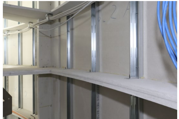
Millimetergenau: Verbindungsstelle von zwei Modulen nebeneinander und zwei Modulen übereinander.
