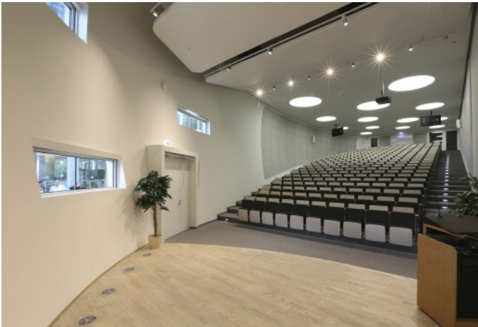
Blick in das runde Auditorium Maximum mit Innenputzarbeiten in Qualitätsstufe Q4. (Foto: Knauf/Halama)
