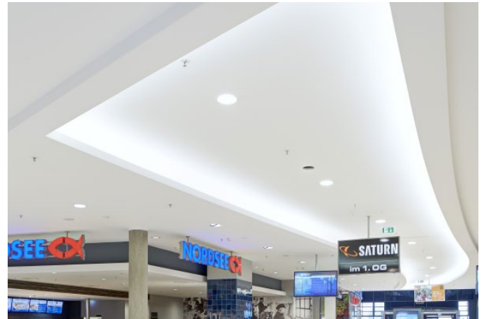
Vertiefte Deckenebenen mit Lichtvouten leiten die Besucher und setzen die Ladenpassagen gekonnt in Szene. Allein 2500 laufende Meter L-Formteile wurden verbaut.
