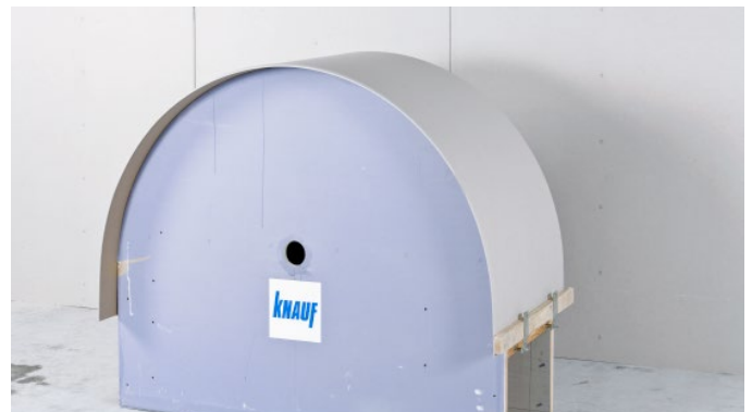
Bild 4: Platte auf Schablone fixieren
