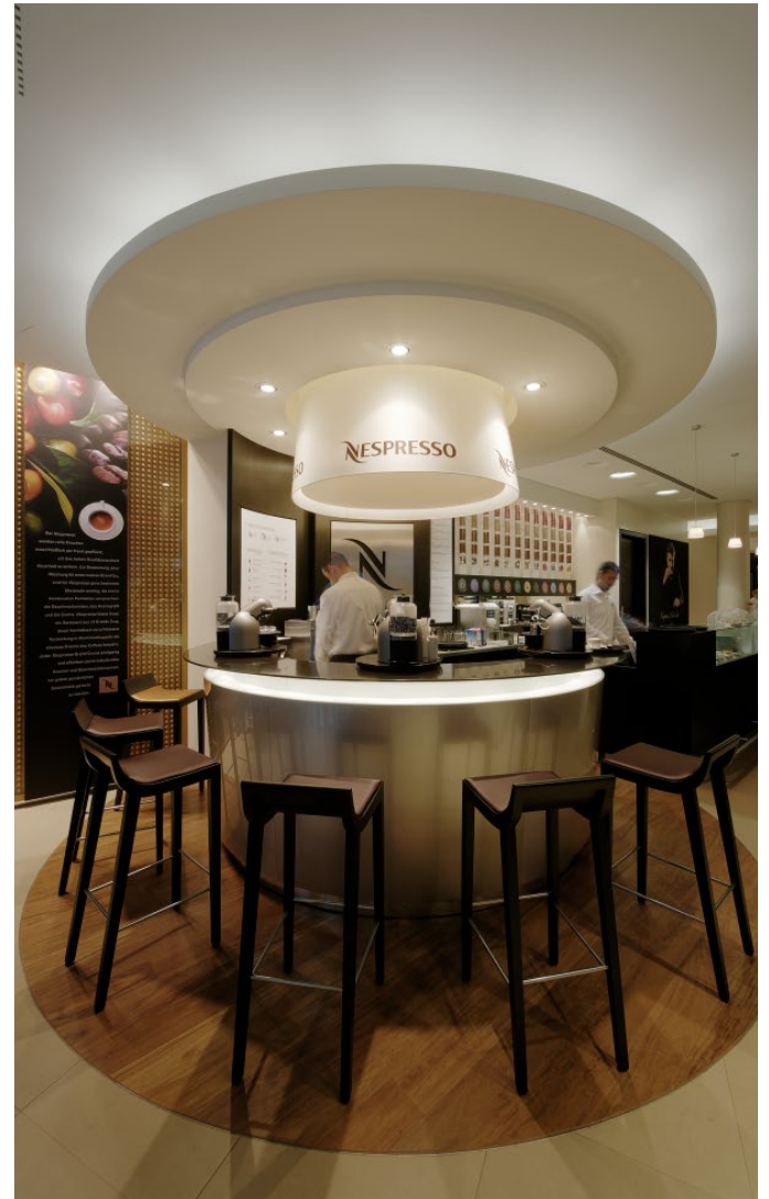
Deckenkonstruktion des Shops – Die Decke ist über mehrere Stufen abgehängt, die Leuchten eingespachtelt.
