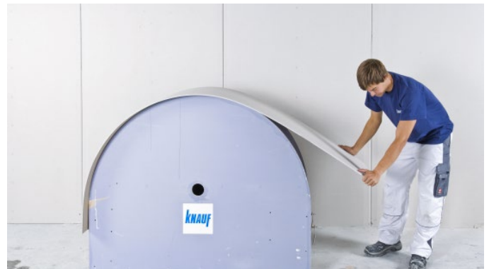
Bild 4: Platte auf Schablone fixieren
