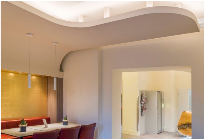
Der Frühstücksraum wurde mit einem Himmel und Sitznischen in Trockenbau neu gestaltet und um einen Loungebereich erweitert.
