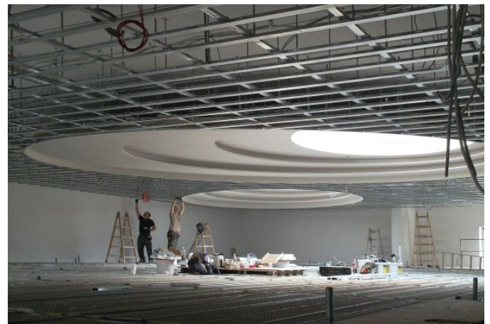
Detail der Deckenkonstruktion im Max-Planck-Institut. (Foto: Ruben Peter Ausbau GmbH)
