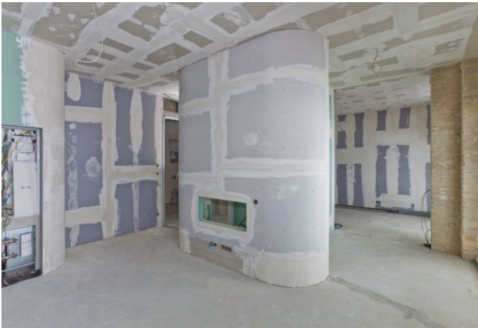
Trockenbau-Know-how von Knauf bildet die Basis – nicht nur für die geschwungenen Wohnskulpturen.
