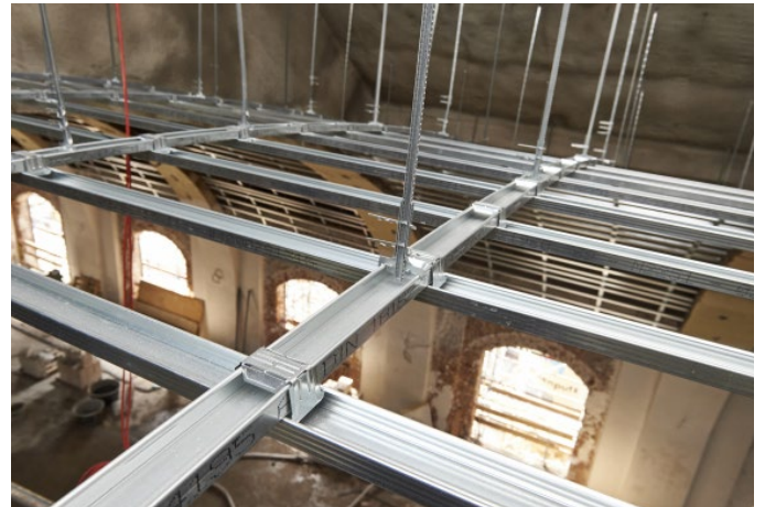
Die gebogenen Grundprofile der Unterkonstruktion wurden im Werk in den erforderlichen Radien vorgefertigt und passgenau geliefert.
