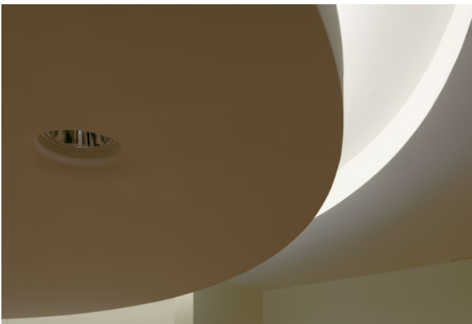
Rundungen in Perfektion. Möglich wird diese Deckenlandschaft mit vorgefertigten Formteilen.
