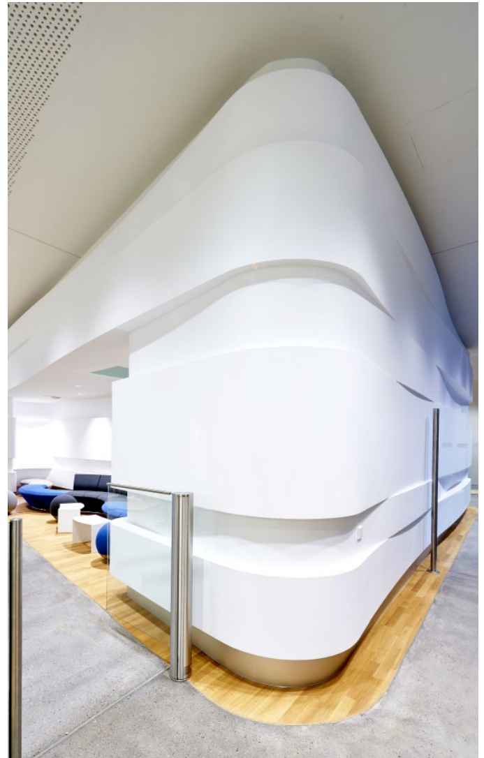
Wie eine Flugzeugnase ragt die Trockenbauwand aus Knauf Formteilen in der Lounge des ZAL Finkenwerder in den Raum.
