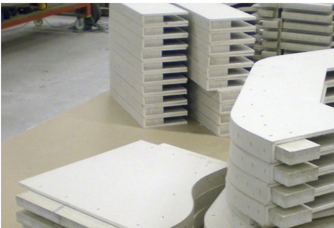
Lamellenteil in der Vorfertigung: Die vorgefertigten Seitenteile der Lamellen sind mit 18 mm dicken Gipsfaserplatten hinterlegt.
