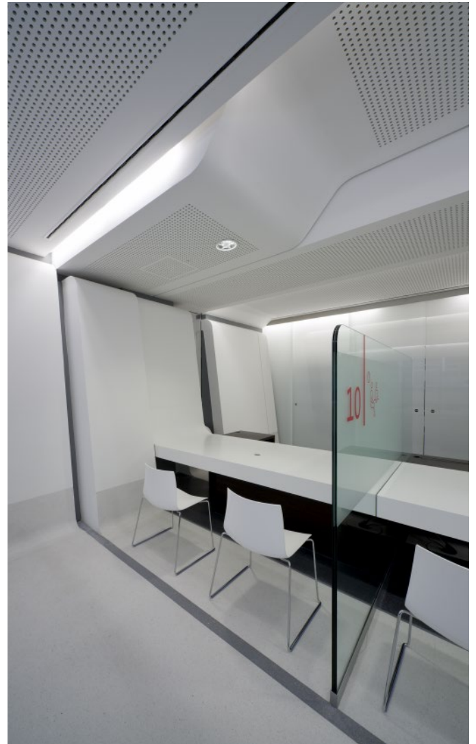
Deckenbekleidung mit Knauf Cleaneo Akustikplatten. (Foto: Knauf/Albert)
