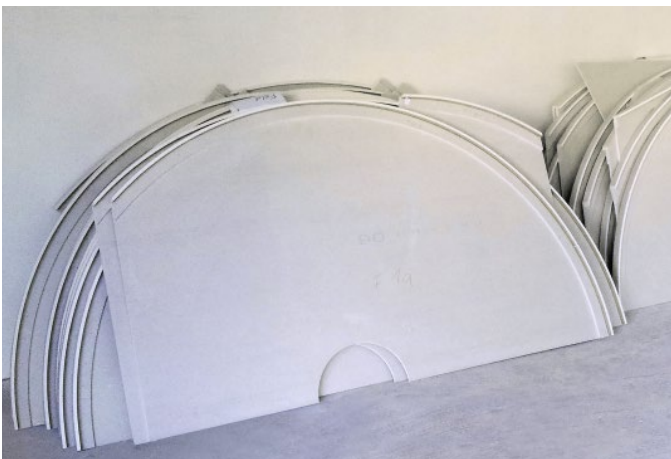
Vormontierter Bausatz für komplett vorgefertigte Deckensegel. (Foto: Jaeger Ausbau)
