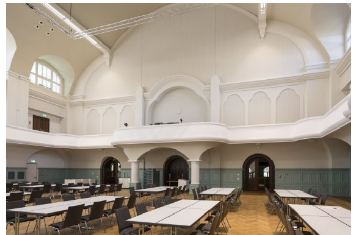
Die Rückseite des Großen Saals ist als Ganzes eine Schallabsorptionsfläche und in Trockenbau entstanden.
