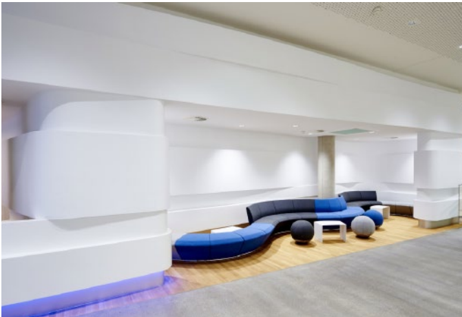
Weich geschwungene, horizontal gegliederte Wandinstallationen aus Knauf Formteilen bilden die Lounge.
