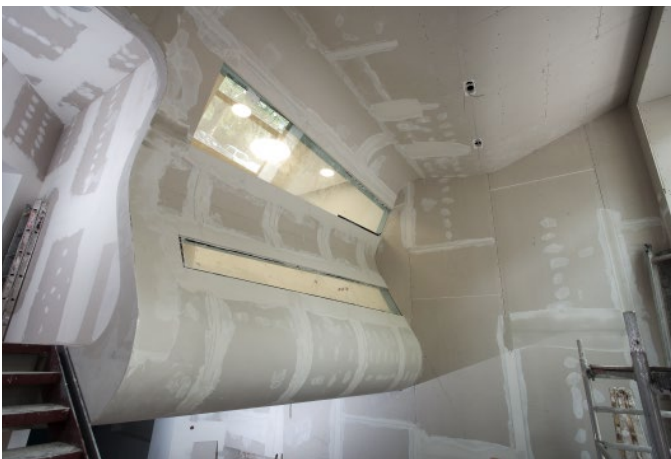
Trockenbauarbeiten von Tief- zum Hochpaterre. (Foto: Gallandi)
