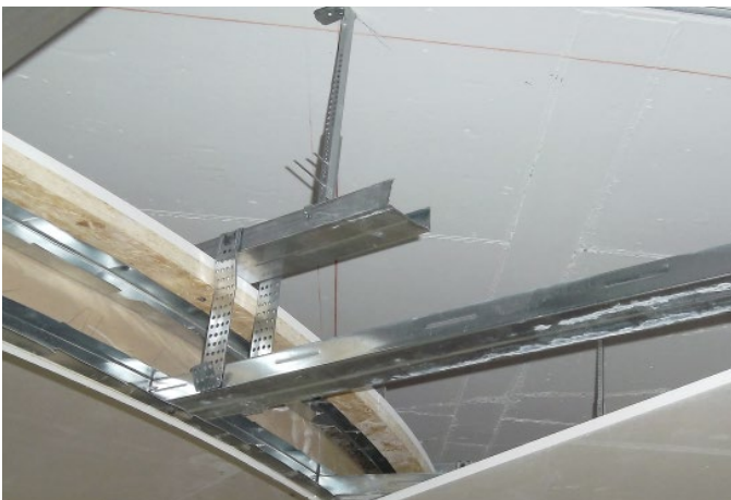
Detail Deckenvorsprung. (Foto: Ruben Peter Ausbau GmbH)
