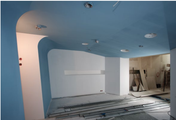
Moderne Biegetechnik zieht sich konsequent durch die Kinderzahnarztpraxis in Berlin. (Foto: Gallandi)
