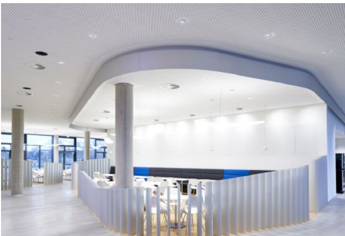
Abgerundete Knauf Formteile befinden sich auch an den Decken der Kantenbereiche im Empfangsbereich des ZAL, abgegrenzt mit Alu-Stelen.
