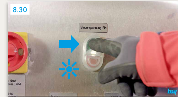
„Kontrol gerilimi açık“ (yeşil düğme) düğmesine basın ► Isık açık
