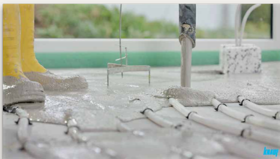
Distribuirea mortarului cu furtunului în suprafață
