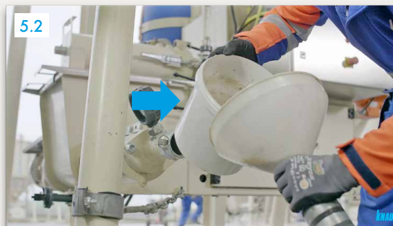
Umplerea șlamului cu pâlnia în furtun
