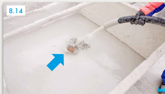
Clătirea furtunului cu apă până la ieșirea sferei de burete
