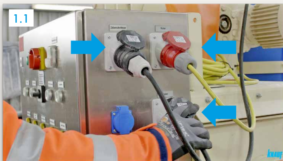
1.1 Verificarea conectorilor electrici
