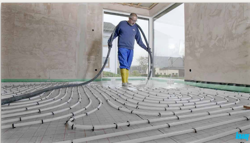
Distribuirea mortarului cu furtunului în suprafață
