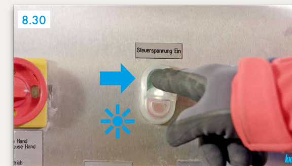
Pritisnuti „Upravljački napon uključen“ (zeleni gumb) ▶ svjetlo uključeno
