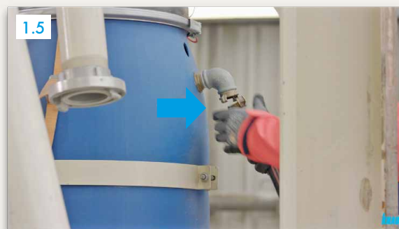
1.5 Crijevo za vodu spojiti na bačvu ili na crpku za vodu
