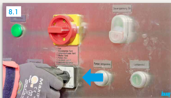
8.1 Okretnu sklopku postaviti na „4-crpkka ručno“
