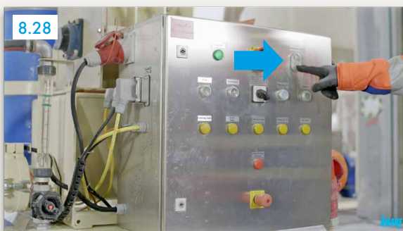
pritisnuti „Upravljački napon uključen“ (crveni gumb) ▶ svjetlo isključeno
