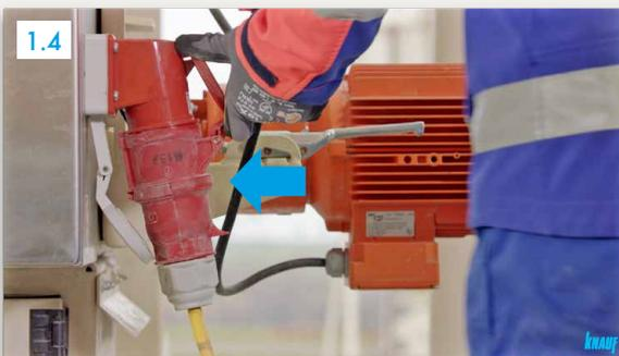
**Baustromverteiler Starkstrom 32 A an Maschine anschließen**
