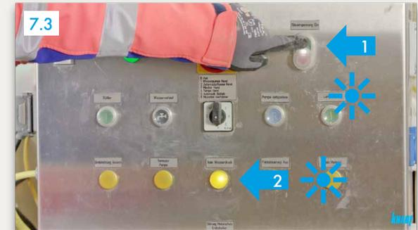
7.3 „Steuerspannung Ein“ (grüner Knopf) drücken ▶ Licht an, „kein Wasserdruck“-Leuchte ▶ Licht an
