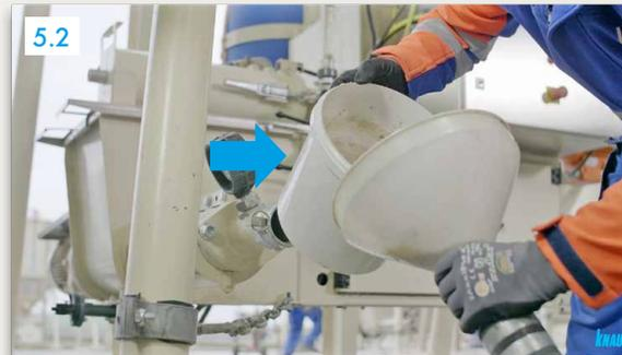
5.2 Schlämme mit Trichter in den Schlauch einfüllen
