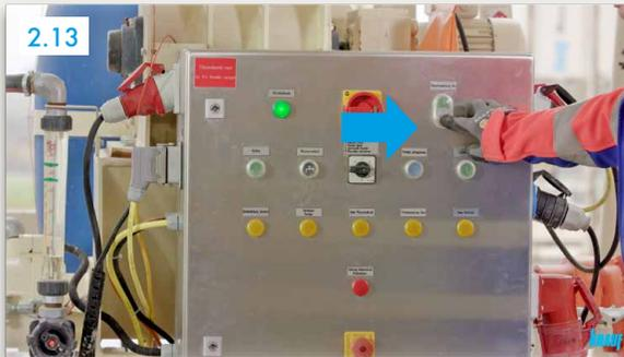
„Steuerspannung Ein“ (roter Knopf) drücken ▶ Licht aus
