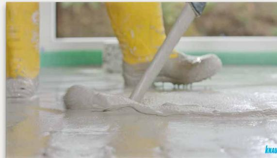
Mörtel mit Schlauch in der Fläche verteilen
