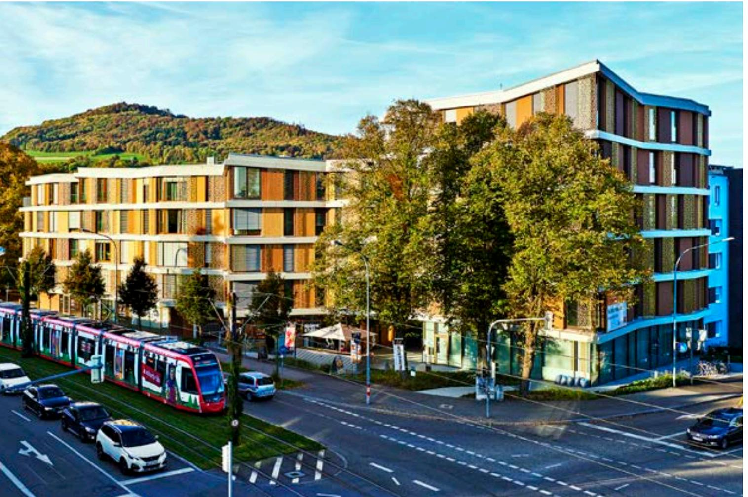
Beim Freiburger Bürogebäude Vauban V6 kam Fassadol TSR in dunklen Farbtönen zum Einsatz, um Schäden durch zu starke solare Aufheizung zu vermeiden.
