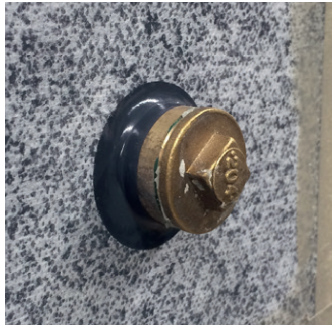
Praxisbeispiel: Rohrdurchführung mit Dichtmanschette
