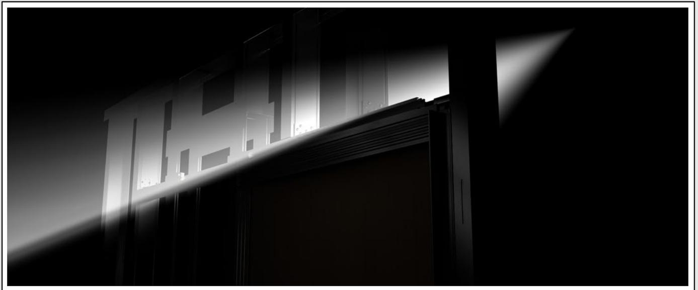
33 Wenn Licht durch die horizontalen Dichtungen fällt, den Auslösepin weiter raus drehen und erneut prüfen.
